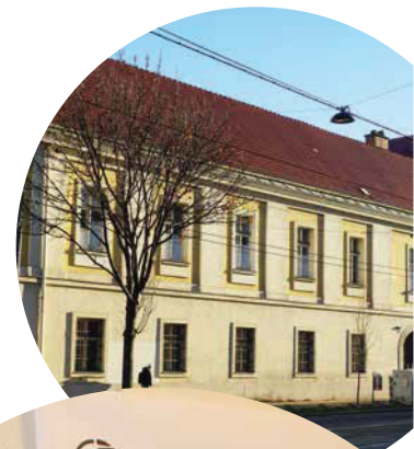
Abb. 1: Transformer-Gebäude am Rennweg 89a im III. Bezirk.
